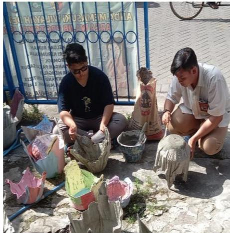
**Gambar 3. Tahap pelapisan ulang pot menggunakan adonan semen**
