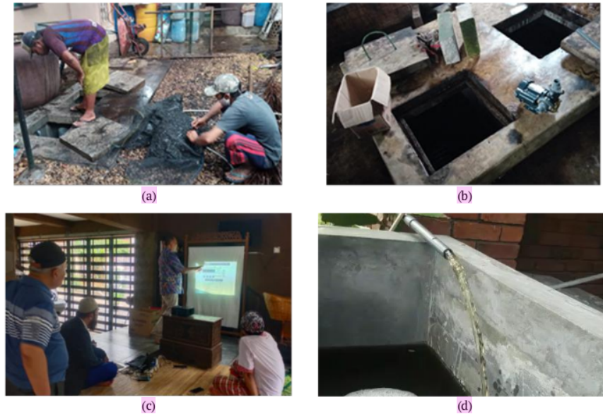
Gambar 9. (a) Pekerjaan memasukkan arang kayu ke dalam bak absorpsi, (b) Instalasi pompa di bak pengendap, (c) Pelatihan operasional IPAL-Pembangkit PV, dan (d) Uji-coba operasional alat ke Mitra 1
