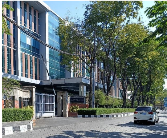
Gambar 4.1 Gedung PT. SMI
