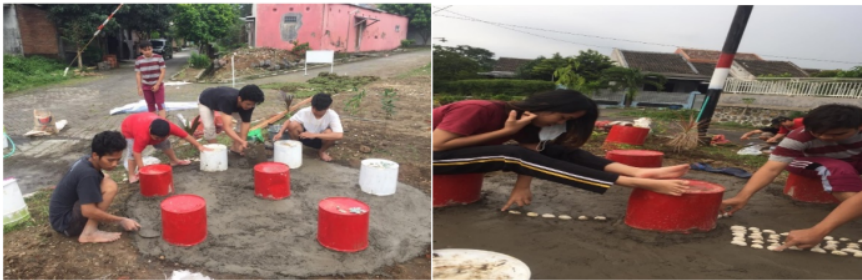
Gambar 8 & 9: Proses Pengecoran Untuk Tempat Duduk Dan Menata Batu Alam Untuk Refleksi Kaki Dan Sebagai Hiasan
