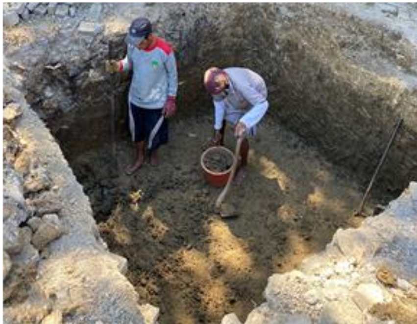
Gambar 6. Pekerjaan galian tanah pada bangunan bak IPAL
