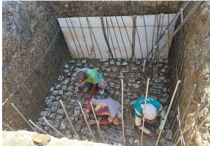
Gambar 7. Pekerjaan pemasangan tulangan besi cor pada bangunan bak IPAL
