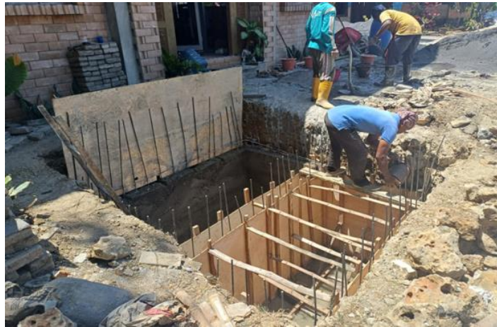
Gambar 8. Pekerjaan pengecoran beton pada bangunan bak IPAL
