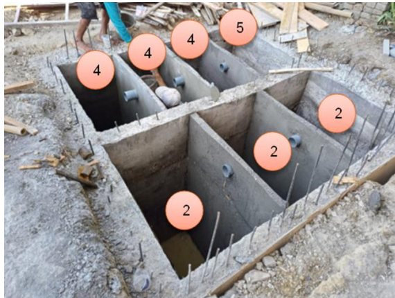
Gambar 11. Pekerjaan plesterisasi pada bak pengendap (2), bak filter arang aktif (4), dan bak kontrol akhir (5)
