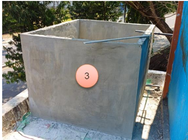
Gambar 10. Pekerjaan bak koagulasi (3) pada bangunan bak IPAL
